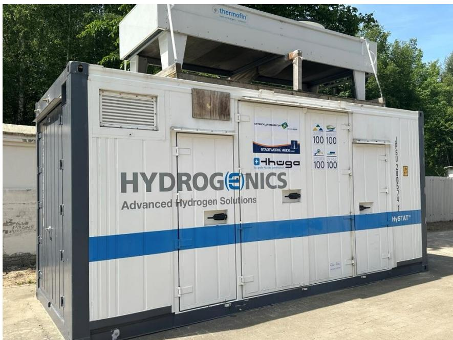
Dieser Elektrolyseur wird zukünftig Wasserstoff in einen Abschnitt des Gasnetzes der Stadtwerke Heide beimischen.
